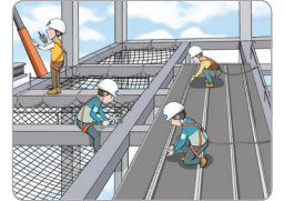
▶ 추락방호망 설치 및 안전대 착용
