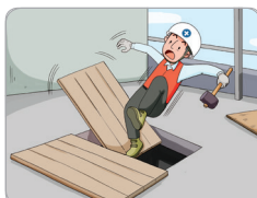
▶ 덮개 설치 불량
